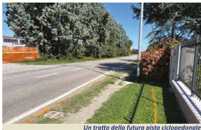
Un tratto della futura pista ciclopedonale
