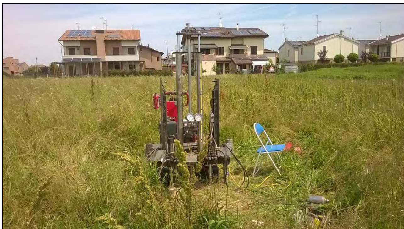
Immagine 2.8-3 Fase di esecuzione CPTU2
