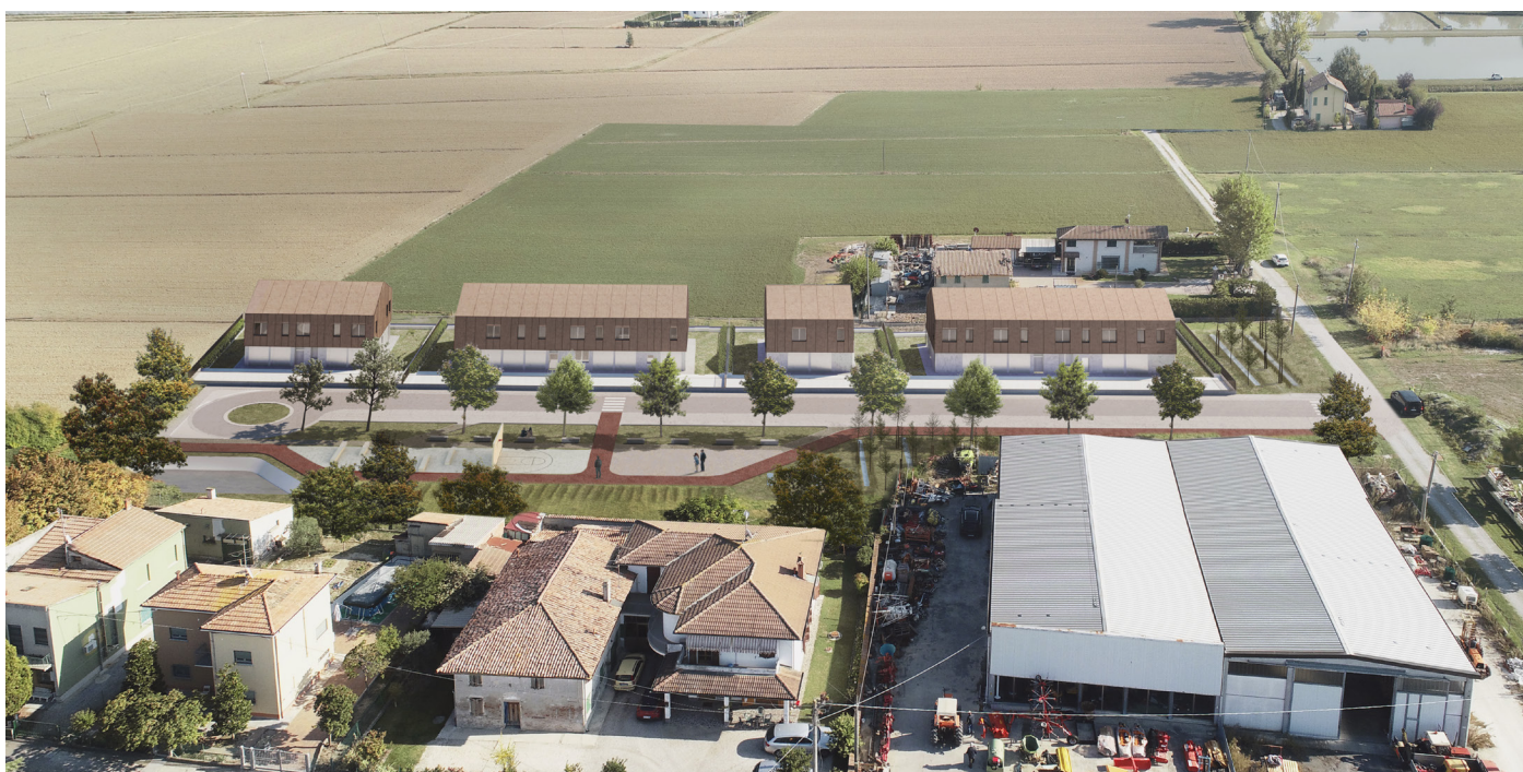
Vista esterna a volo d'uccello - Area di intervento
