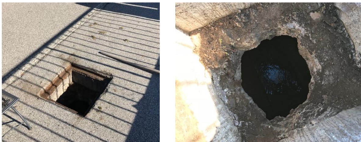
Figura 4 – Immagini dei pozzetti esistenti della fognatura mista su Via Rubizzano.
