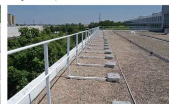
Fig. 2 - esempio PARAPETTI ZAVORRATI
