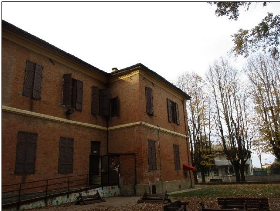
Foto n°6 - Individuazione delle aperture poste in prossimità delle angolate.
