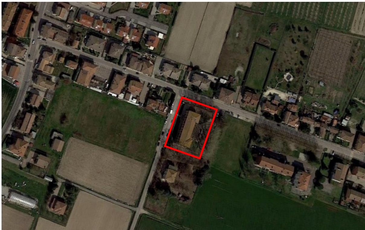
Foto n°1 - Inquadramento dell'edificio nel contesto.
