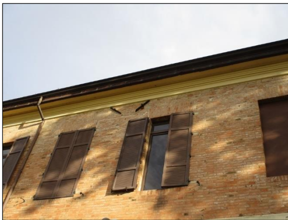
Foto n°2 - Individuazione dei capi-chiave dei tiranti installati lungo la sommità dei prospetti.
