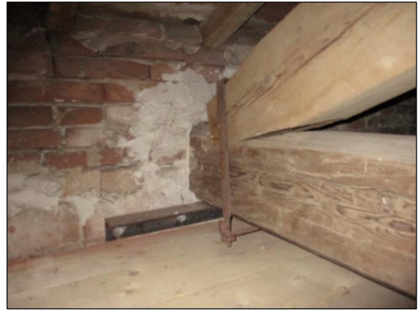
Foto n°5 - Presidio installato in prossimità dell'appoggio delle capriate.
