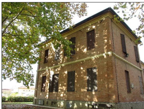
Foto n°9 - Individuazione delle aperture poste in prossimità delle angolate.
