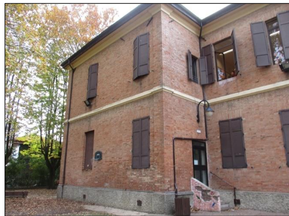
Foto n°3 - Individuazione dei capi-chiave dei tiranti installati lungo la sommità dei prospetti.
