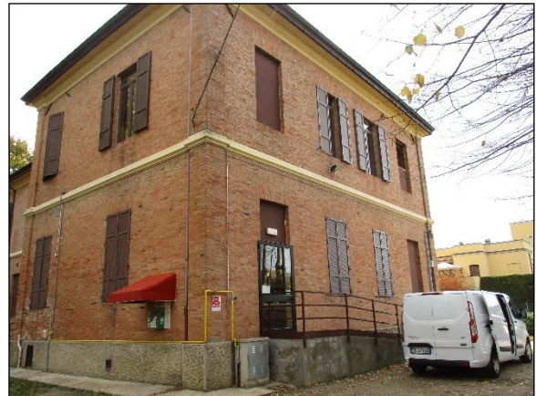
Foto n°7 - Individuazione delle aperture poste in prossimità delle angolate.
