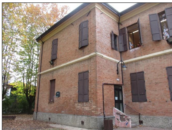
Foto n°8 - Individuazione delle aperture poste in prossimità delle angolate.
