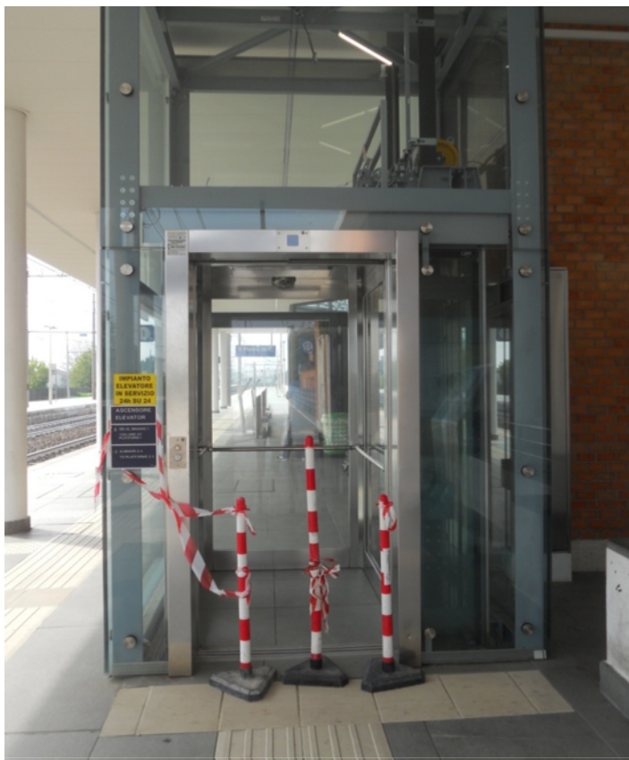
Martedì 18 settembre 2018: ascensore fuori uso.
